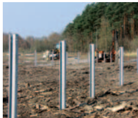
Der Bau des Solarparks „Am Kamp“ ...
